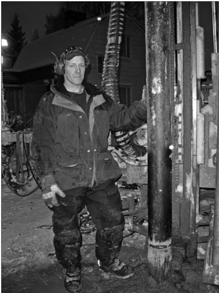
Jimmy poserar vid sidan om foderröret som precis svetsats ihop.
