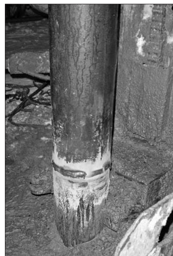
Foderröret måste vara helt efter sammansvetsningen.
