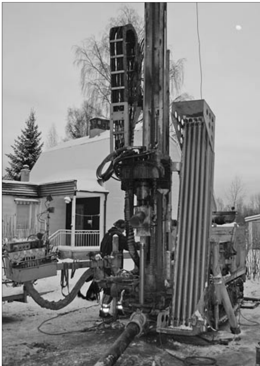
Borragregat med borrstänger i kasett.
