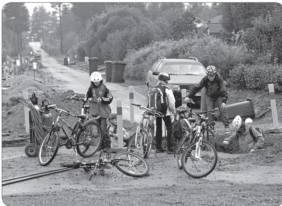
En bild tagen under tiden fjärrvärmen höll på att dras under förra året i Hamptjärnmoran. Fotograf: Dyveke Hedström.
