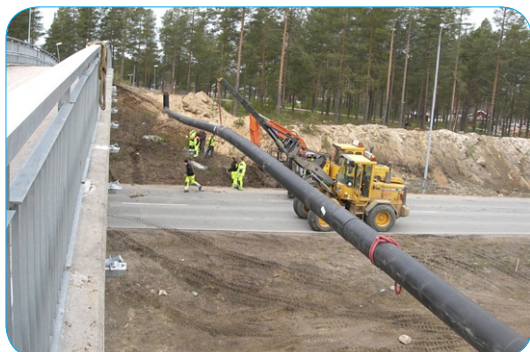
Äntligen fjärrvärme till Heden! Fjärrvärmerören är också en symbol för hur vi och våra bostadsområden hör ihop med varandra. Bild: Dyveke Hedström.
